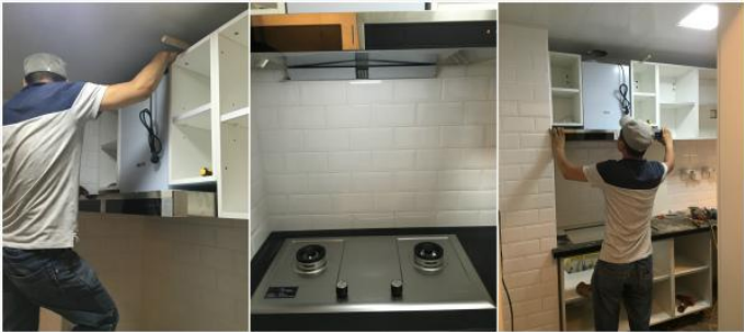
▲油烟机和吊柜配合安装
